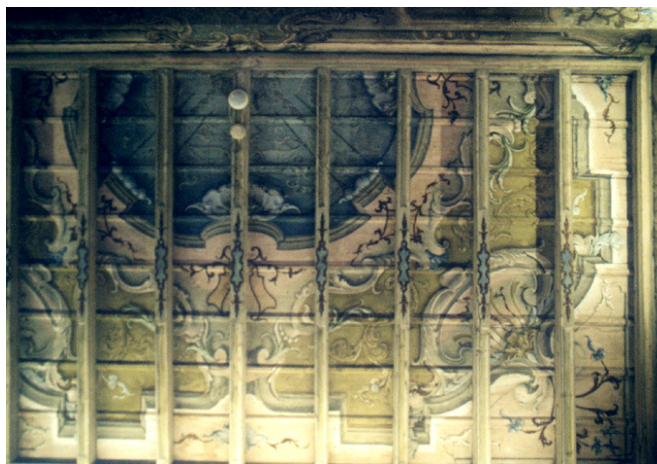
Fig. 13 Plafond in de kamer van Carlotta
