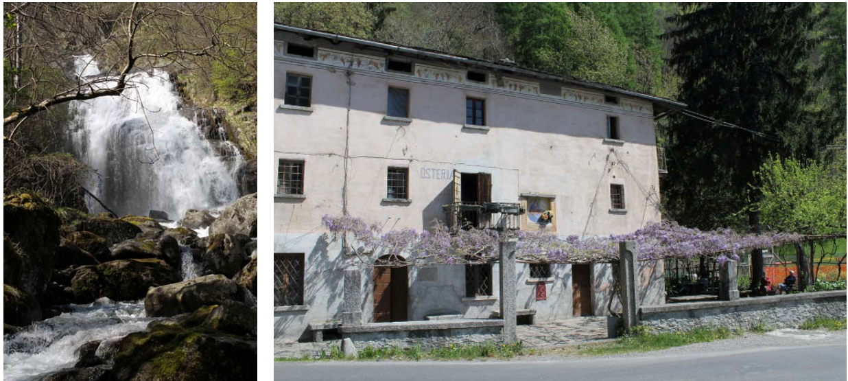
Fig. 11 Ponte del Baffo. links de waterval in de Cavrocco, rechts het vroegere hotel met blauwe regen
