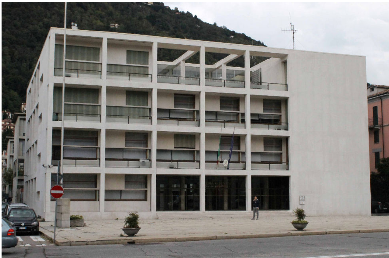
Fig. 3 Het Casa del Fascio
