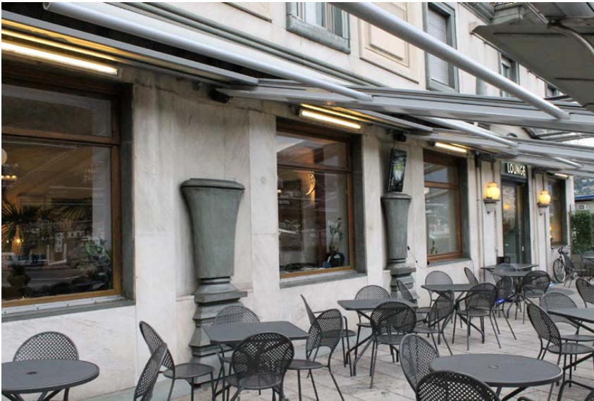
Fig. 9 Gevel van het hotel Metropole-Suisse
