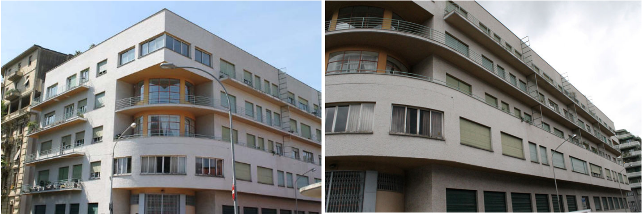
Fig. 10 Novocomum met links het gebouw van Caranchini Fig. 11 Zijkant van Novocomum
