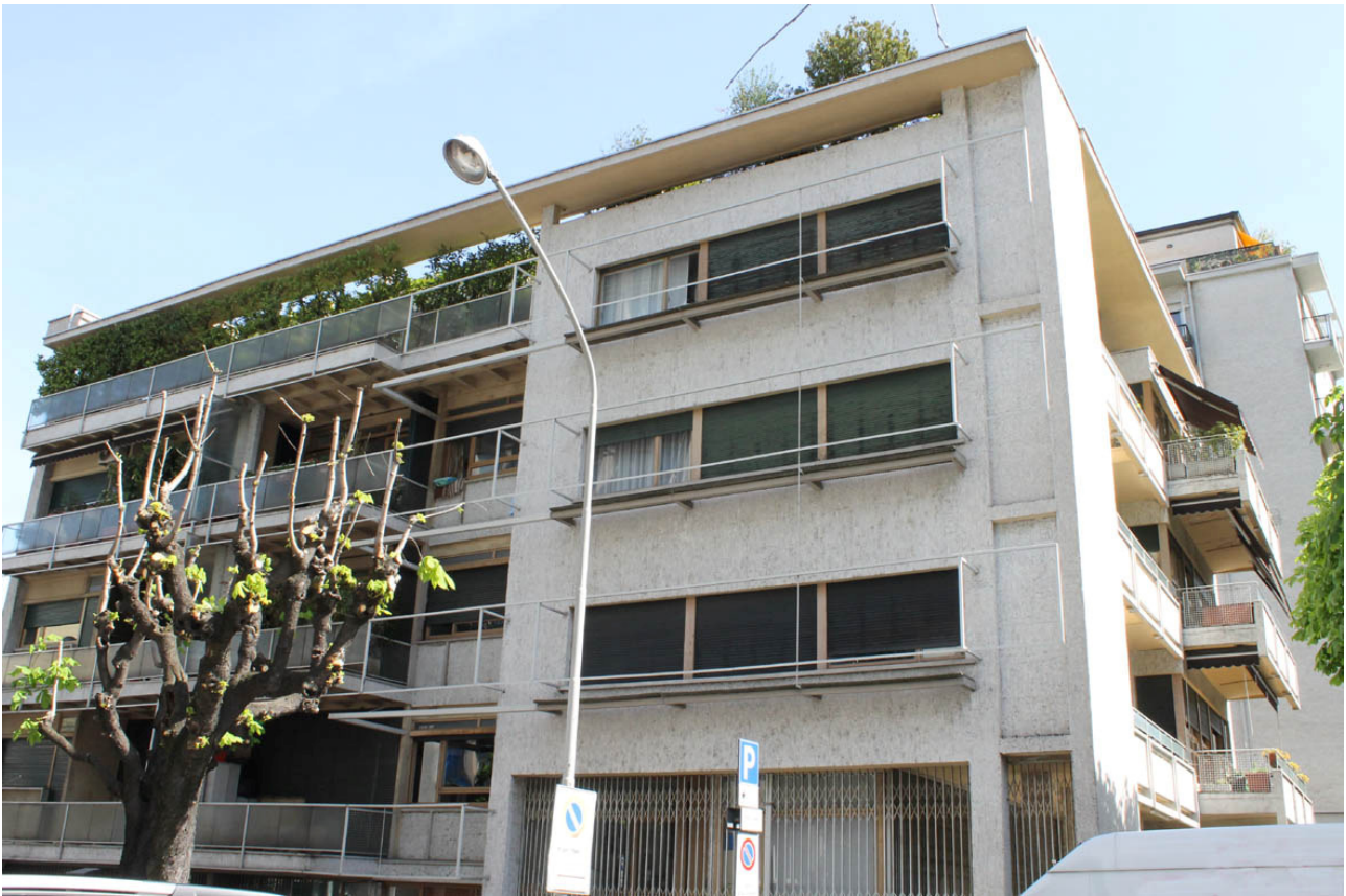
Fig. 15 Casa Giuliani-Frigerio gezien vanuit zuid-west
