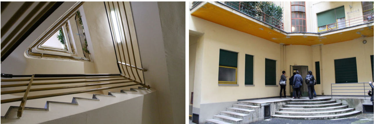
Fig. 12 Novocomum. Links: trappenhuis, rechts: binnenplaats
