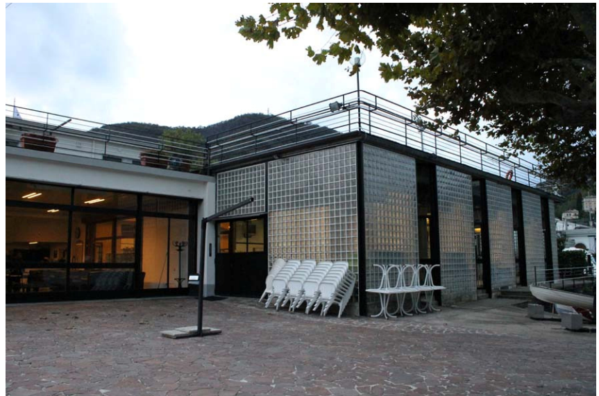
Fig. 19 Achterzijde roeivereniging met trainingsruimte
