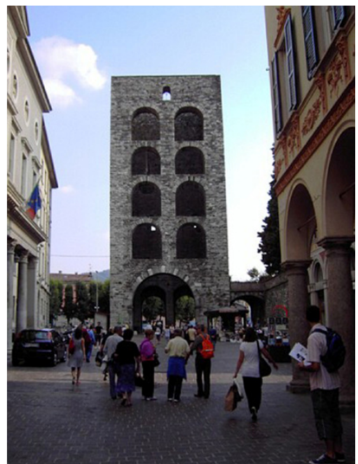
Rechts: De Porta Torre met links het Liceo Classico en rechts het palazzo Martignoni
