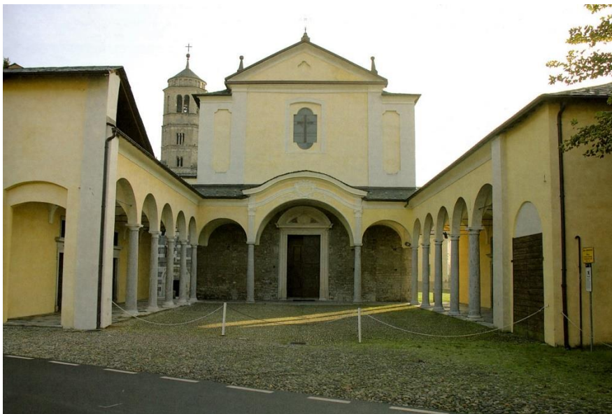
Voorgevel en portico SVincenzo
