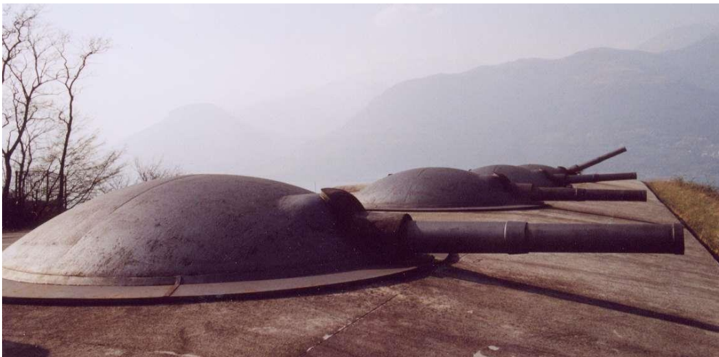
Fig. 5 De vier 149 mm Schneiderkanonnen van het fort Montecchio
