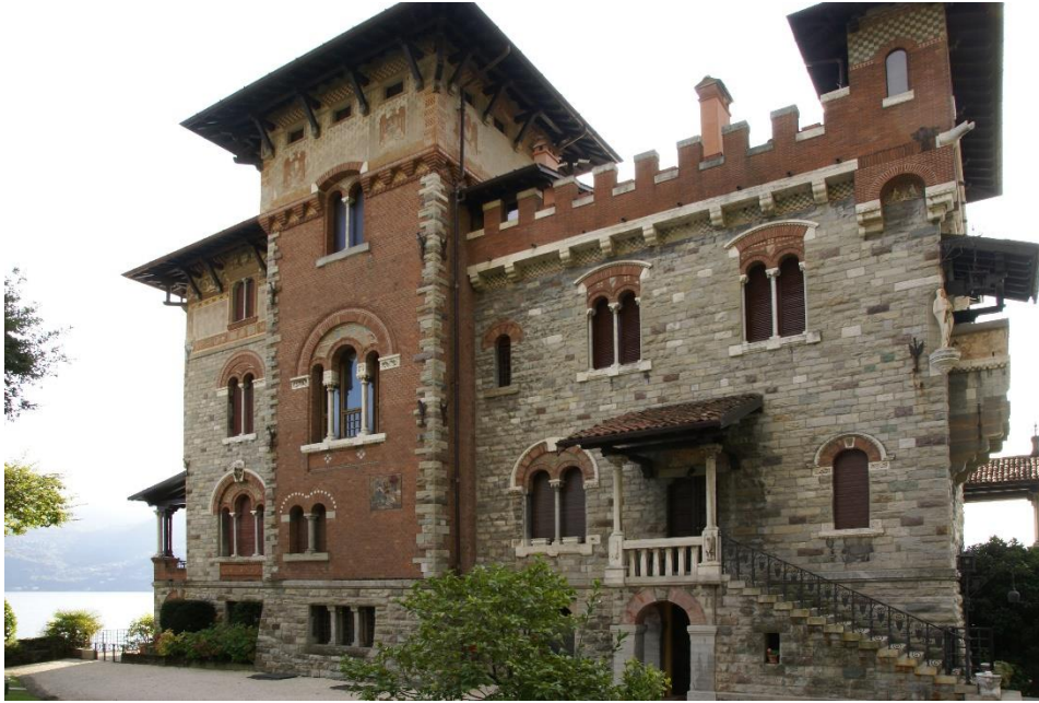
De noordgevel van villa La Gaeta, opvallend door het gebruik van verschillende steensoorten
