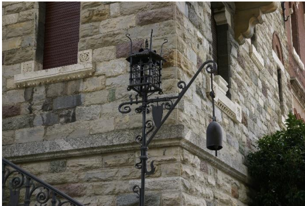
De gevelmuur met lantaarn
