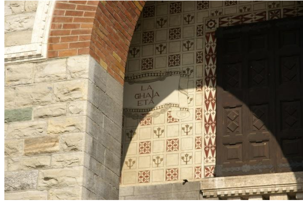
tegeldecoratie op de zuidgevel
